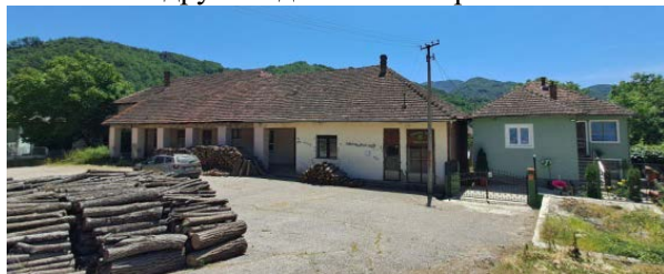
Задружни дом на к.п. бр. 2226
