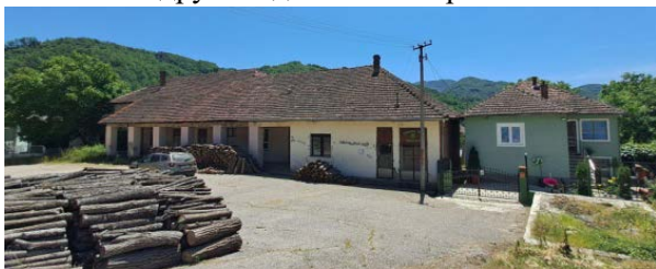
Задружни дом на к.п. бр. 2226
